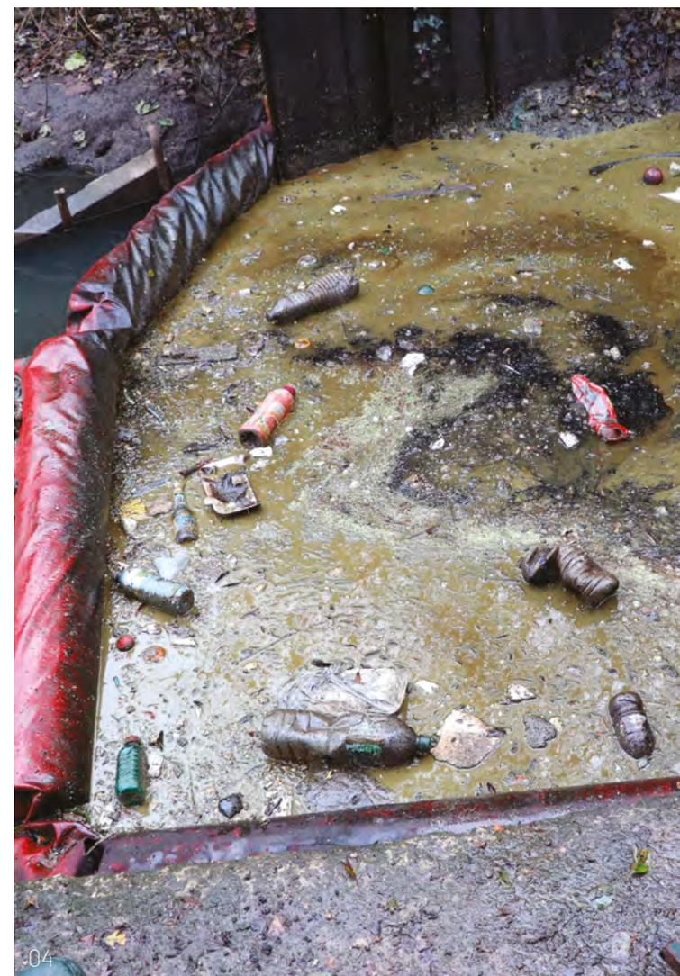
02. Des tests à la fluorescence ont été effectués dans les réseaux. | 03. L'entreprise Suez a réalisé un pompage des eaux polluées. | 04. Un barrage flottant a été installé dans la petite fosse Montalbot.
